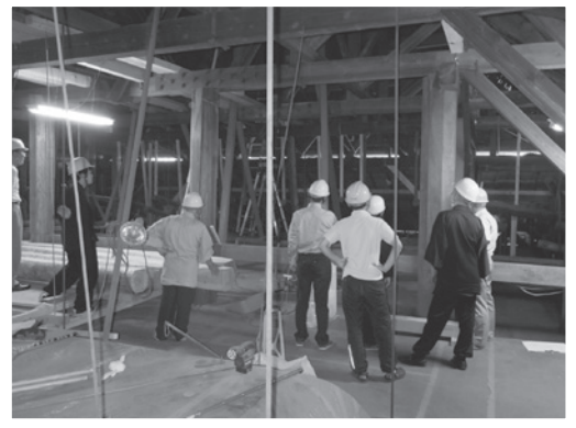
耐震補強工事の中の本堂屋根裏
