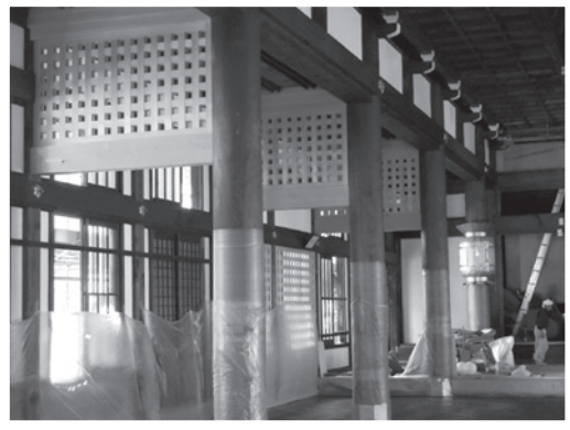
補強した本堂内部
